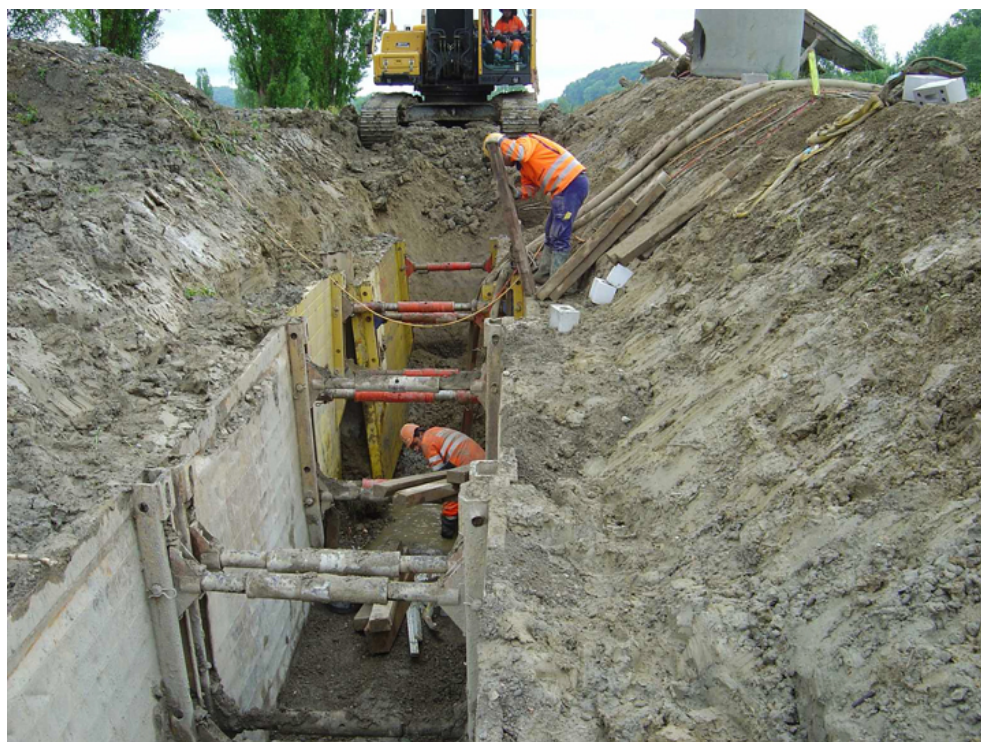
Nouvelle conduite principale vers la station de pompage
