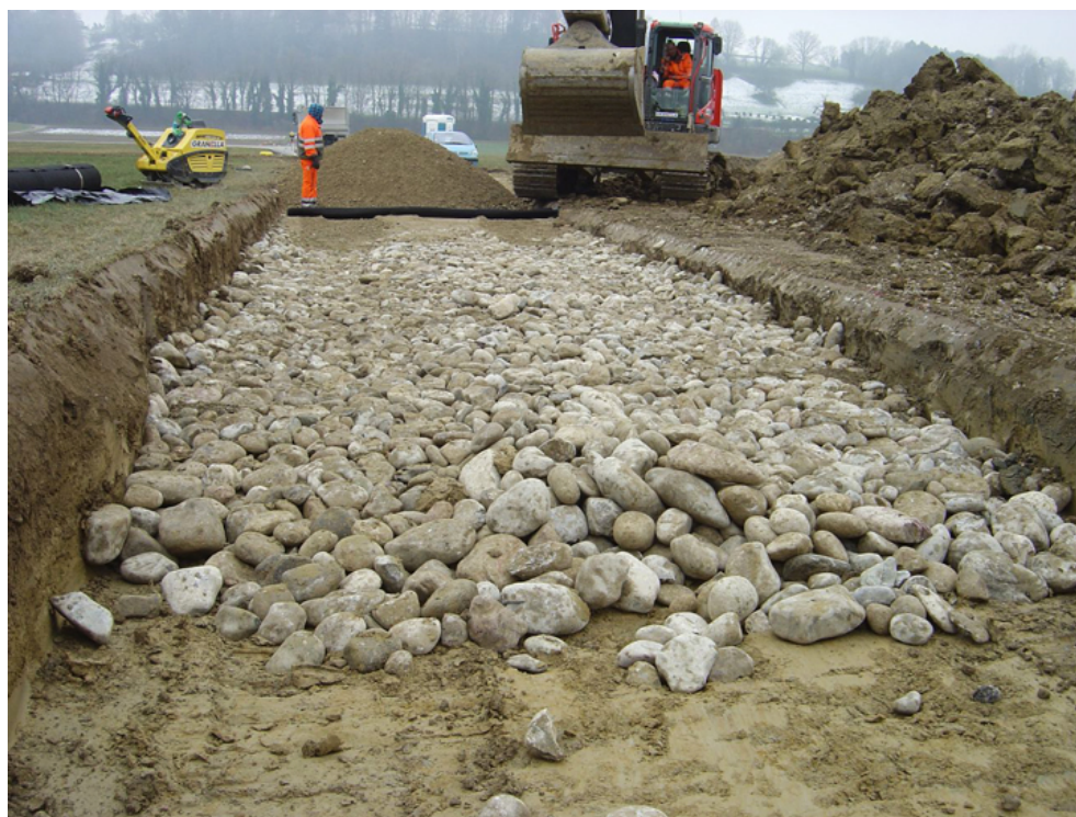
Renforcement de la superstructure avec moellons en bossage et du géotextile.
