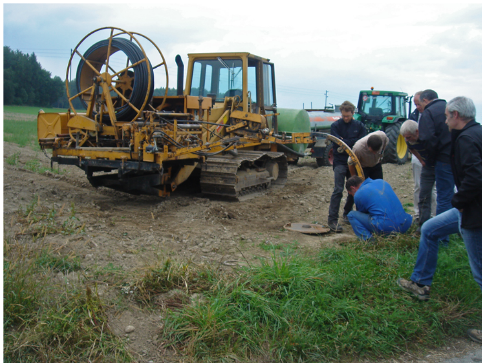
Débouchage d'une canalisation de drainage obstruée
