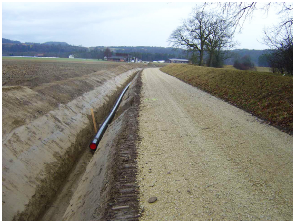
Aménagement d'une conduite d'amenée d'eau
