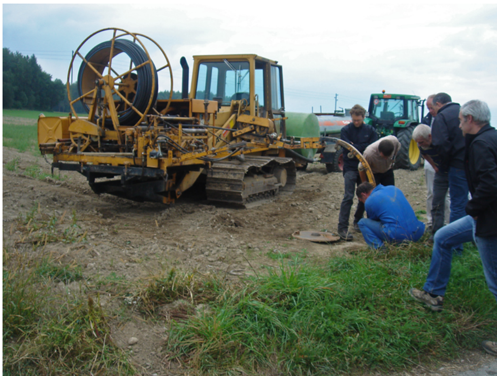
Eine verstopfte oder verschmutzte Drainageleitung wird gespült.
