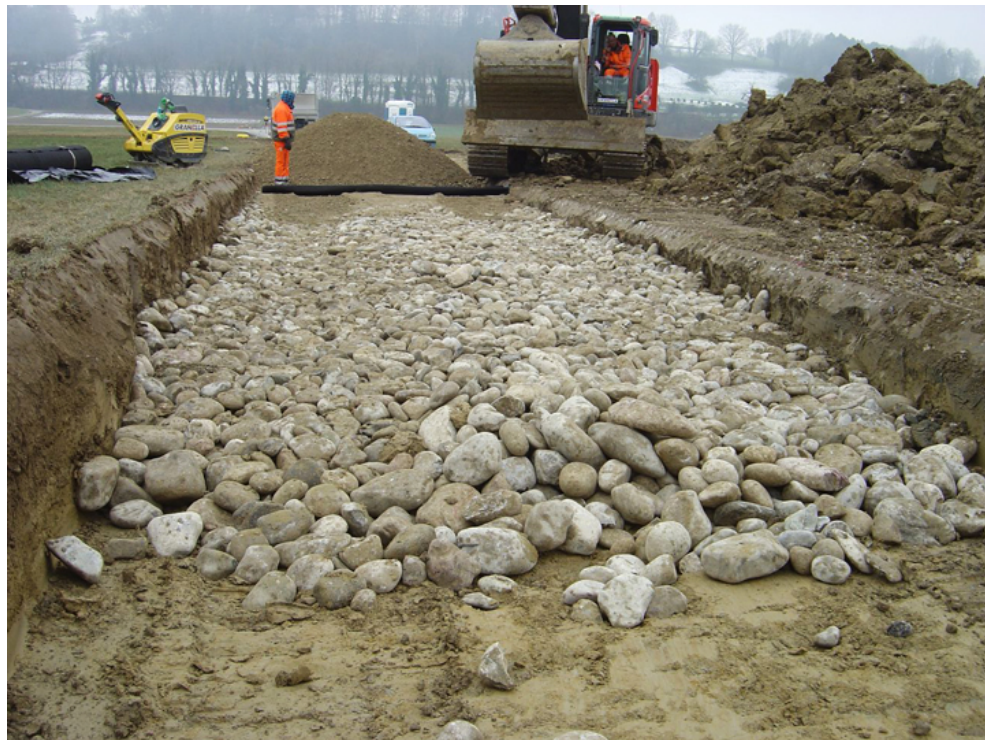
Verstärkung des Oberbaus mit Bollensteinen und Geotextil
