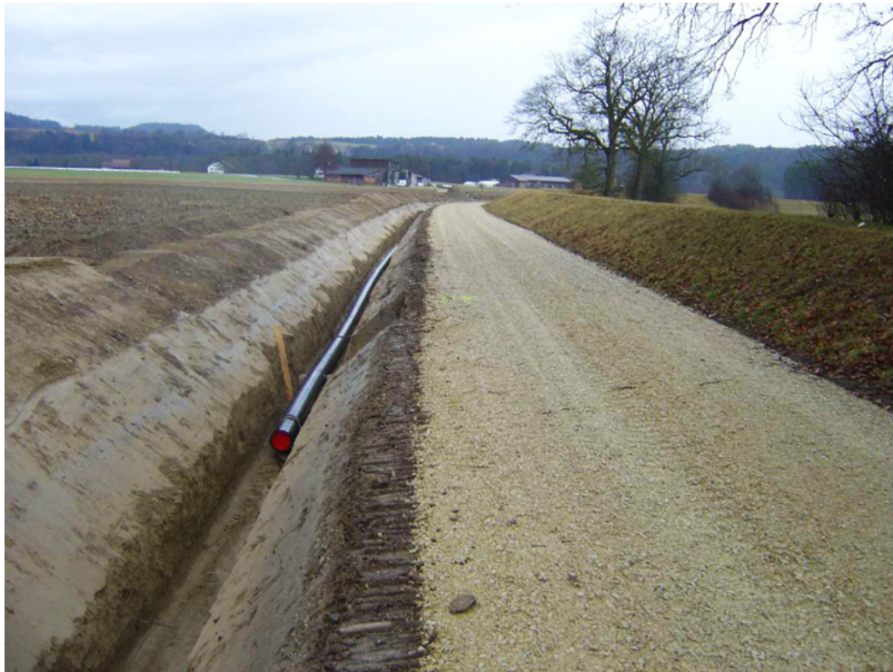
Bau der Versorgungsleitung
