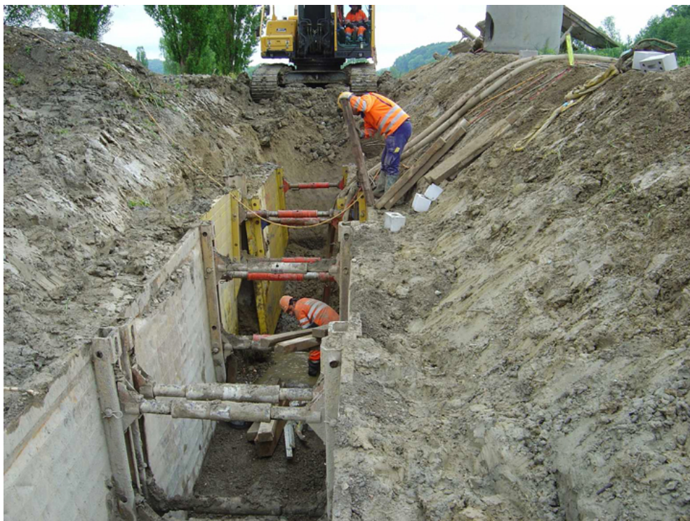
Neue Hauptleitung zum Entwässerungspumpwerk in 4 m Tiefe
