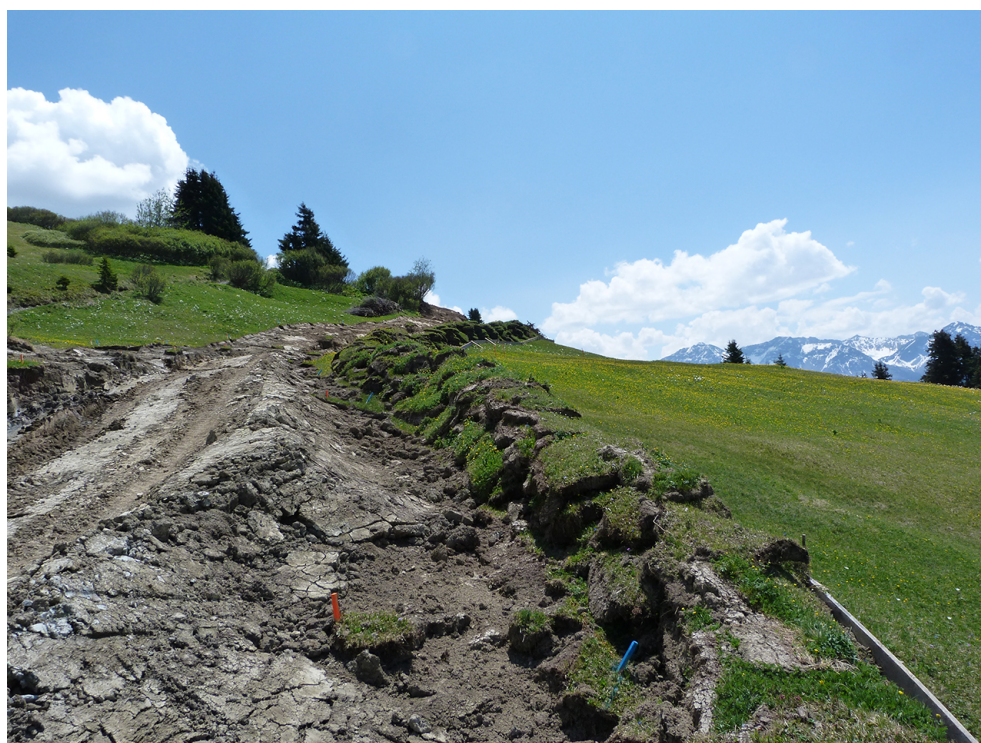
Les plaques de gazon sont entreposées tout le long du chemin, réparties dans la zone de pivotement de la machine d'excavation.
